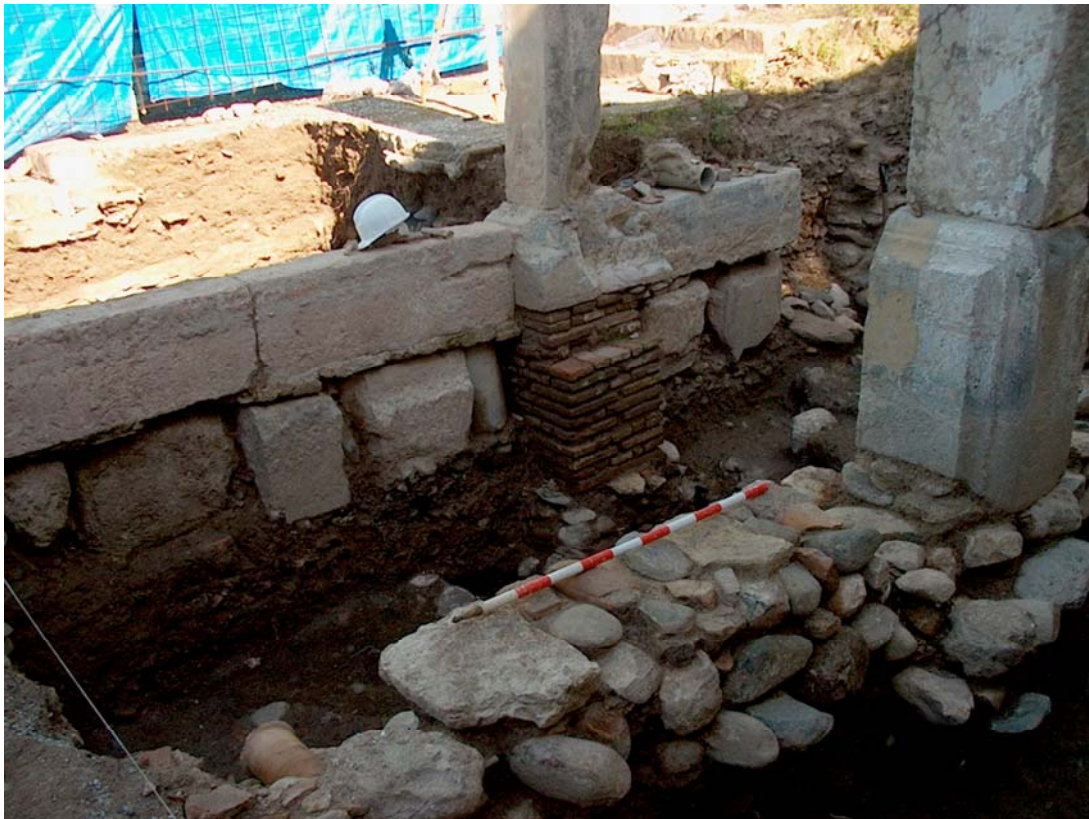
Lám. I- Vista de la excavación al interior del inmueble con multitud de sillares, sillarejos y otros elementos, algunos moldurados. En segundo plano el muro perimetral Oeste en cuya cimentación —en su hilada inferior— se localizó la inscripción.
